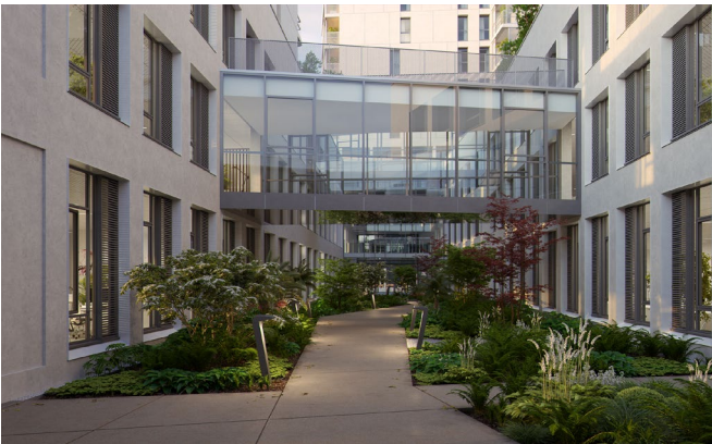
Vue intérieure du patio du siège en rez-de-chaussée
